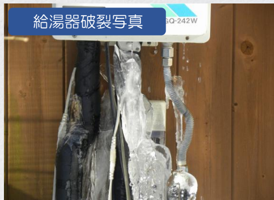
水道管破裂写真
